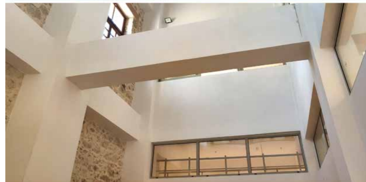
ΟΛΟΚΛΗΡΩΣΗ ΝΕΟΥ ΒΡΕΦΟΝΗΠΙΑΚΟΥ ΣΤΑΘΜΟΥ ΣΤΙΣ ΜΕΣΑΜΠΕΛΙΕΣ | 1η φωτογραφία ΟΛΟΚΛΗΡΩΣΗ ΝΕΟΥ ΚΔΑΠ ΜΕΑ ΣΤΗΝ ΑΡΧΙΕΠΙΣΚΟΠΟΥ ΜΑΚΑΡΙΟΥ | 2η φωτογραφία
